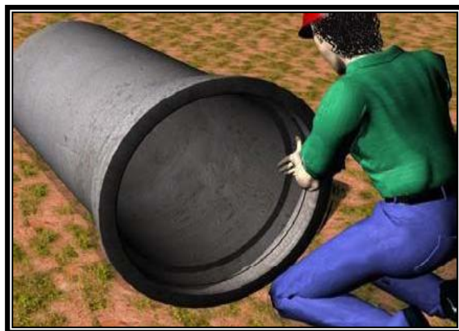
Figura 15 - Lubrificação do anel de borracha
