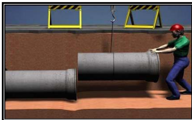
Figura 16 – Acoplamento de tubos de concreto
