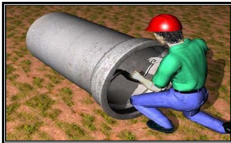
Figura 14 - Colocação do anel de borracha
